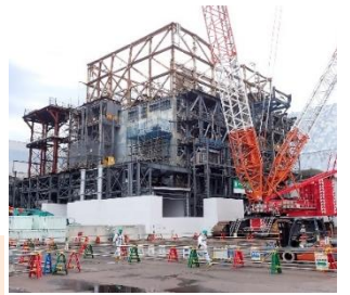
1号機の大型カバー設置の様子
