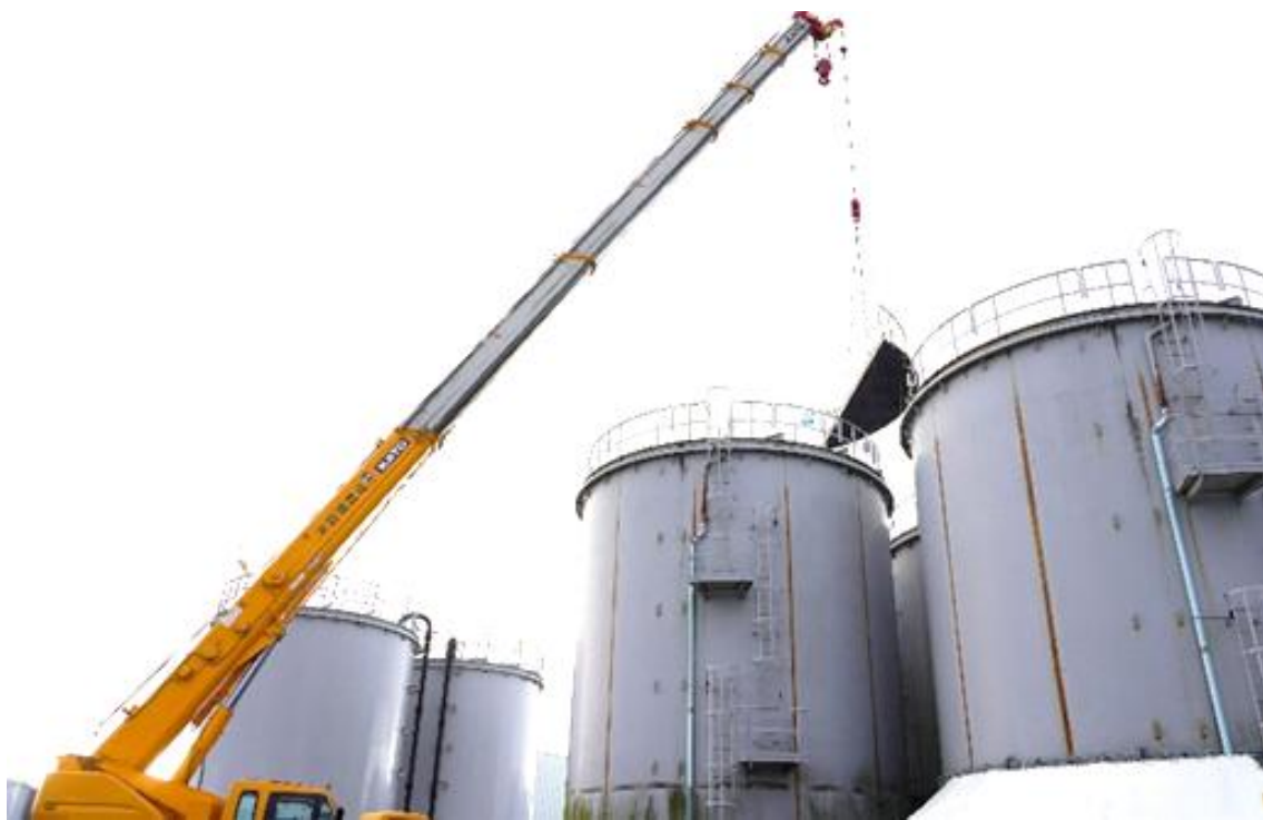
J8エリアタンクの天蓋を撤去する様子（2026.1.20）
