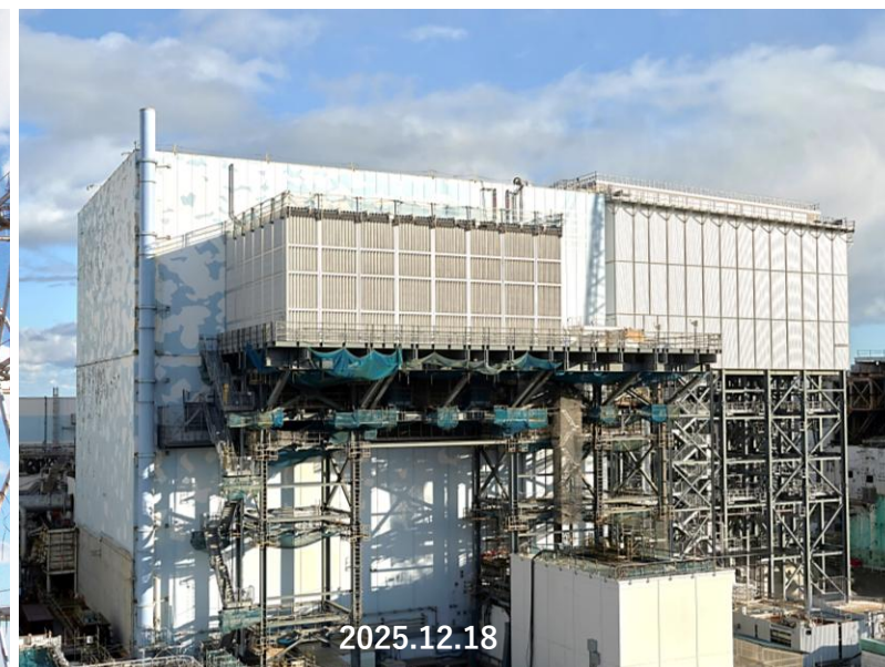
使用済燃料取り出し構台 設置
