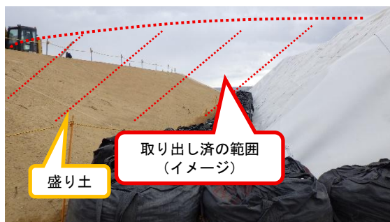
(写真 1－3) 第 1 工区の状況 ※左の盛り土は、瓦礫類の撤去後に造成されたもの
