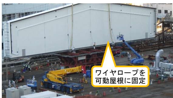
(写真2) 1号機北西側ヤードにおける可動屋根へのワイヤロープ取り付け作業の実施状況
