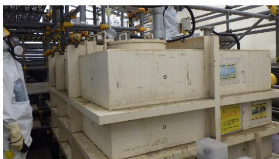
(写真 1-2) No. 4 中継タンクの設置状況
