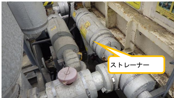
(写真 2) ストレーナーの設置状況
