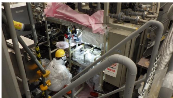
(写真 5) pH 計のサンプリング配管の 取替作業
