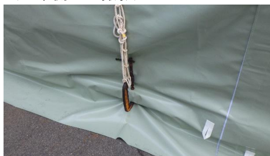
(写真 2) カバーの固定状況
