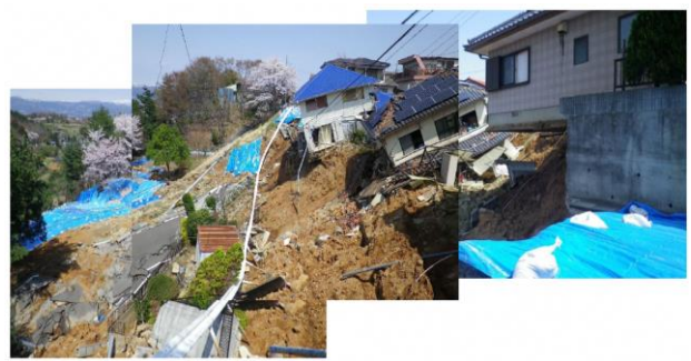
(d)液状化による側方流動
