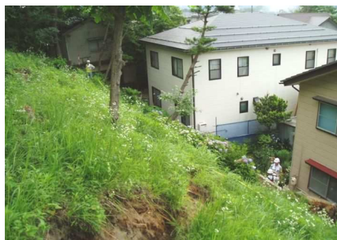
写3-8 のり面のクラックの例
