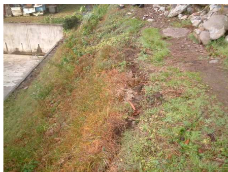
写3-8 のり面のクラックの例
