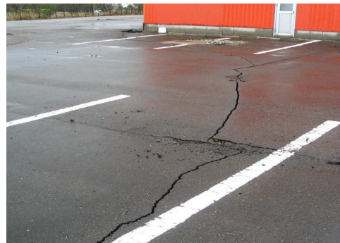
写３－２ 宅地地盤のクラックの例
