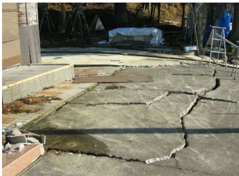
写３－２ 宅地地盤のクラックの例
