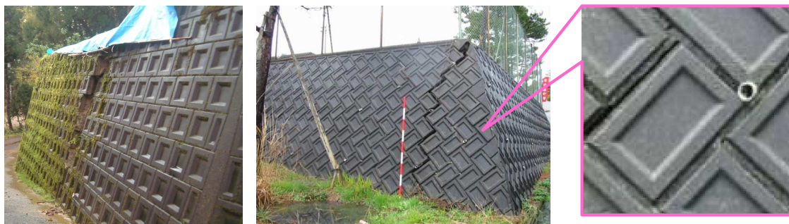
(a) 水抜穴が無い前傾した擁壁 (b) 水抜穴が 20 mm と小さい事例
