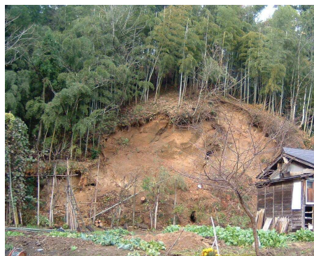
写 3-10 のり面のガリー浸食の例
