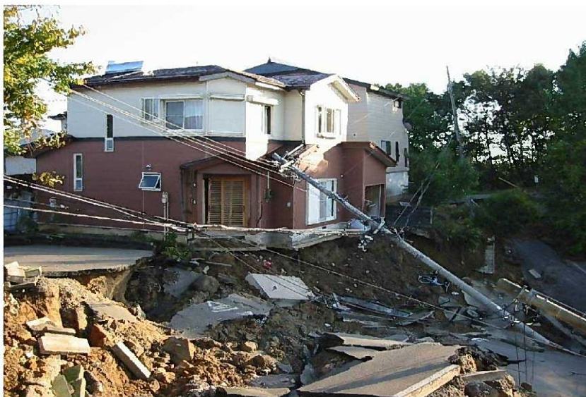
新潟県中越地震の被害
