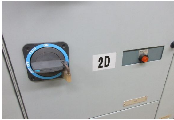
（写真２）電源盤Ａの点検に伴い、一時的に希ガスホールドアップ建屋の送風機へと仮設電源を供給していた電源盤Ｂ
