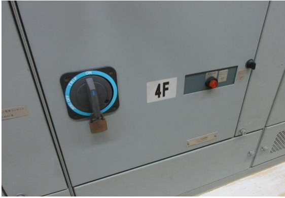
（写真１）通常時に１号機希ガスホールドアップ建屋の送風機へと電源を供給する電源盤Ａ
