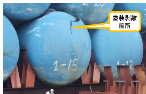
(写真1②) 横置き型タンク表面の塗装の状況(ネット網による剥離防止)
