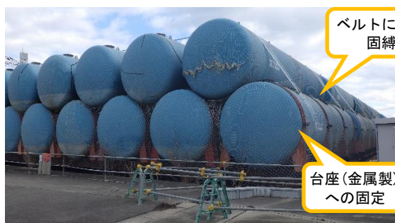
(写真1①) ブルータンクエリアDにおける横置き型タンクの固定状況
