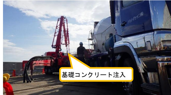
(写真 2②) 保護カバー（コンクリート部）設置工事の状況②
