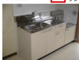
⑤台所の水栓更新(シングルレバー混合水栓付き)
