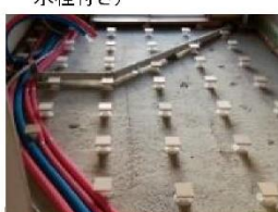
⑥⑦⑧浴室・洗面所・台所へ給湯配管設置
