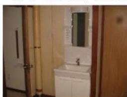
③洗面所へキャビネット型洗面化粧台設置(シングルレバー混合水栓付き)
