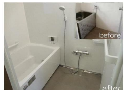
②浴室へユニットバス(シャワー付き混合水栓付き) ・手すり設置
