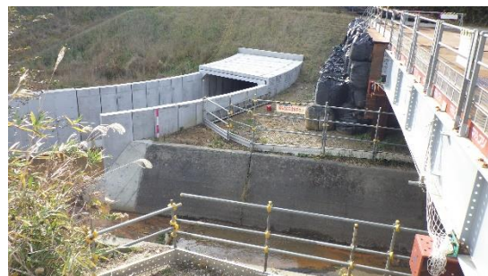
(写真 5 ②) 暗渠式導水の状況
