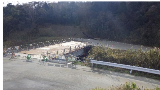
(写真 4) 栈橋の設置状況
