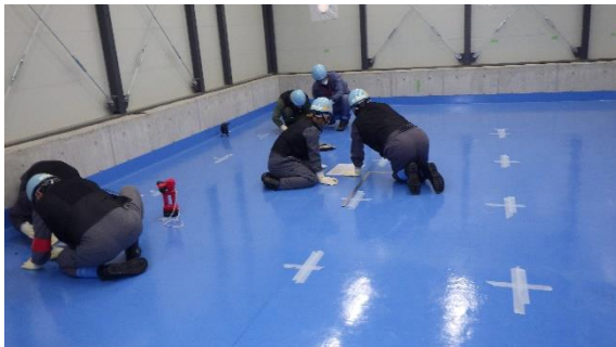
(写真 3－2) 墨出し作業の状況
