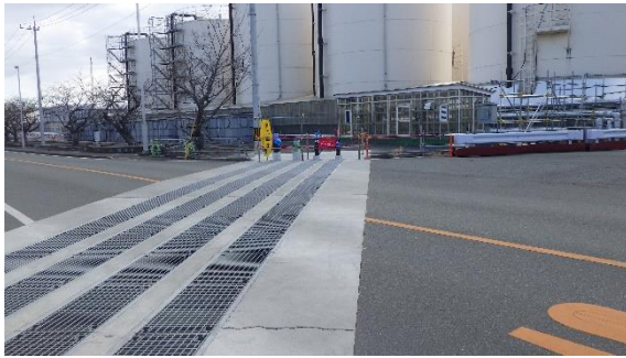
(写真 2－1) 道路を跨ぐ区間の配管敷設状況① ※手前が高台集水タンク設置エリア
