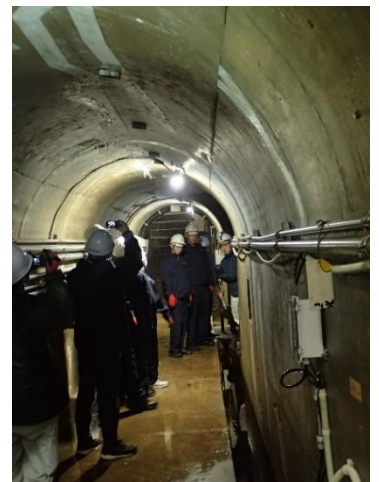
ダム監査廊見学の様子
