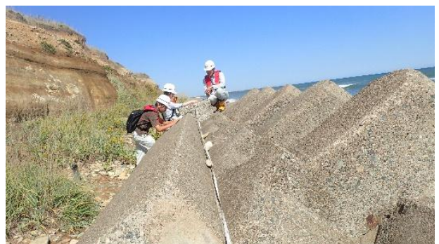
北夫沢海岸:被災調査の様子
