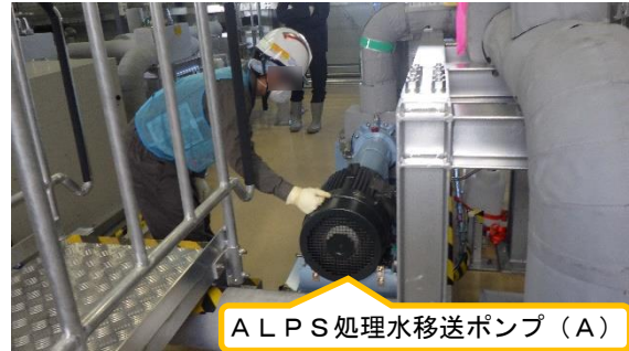
(写真2②) ポンプの稼働状況確認
