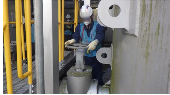
(写真1②)連結弁の全開作業
