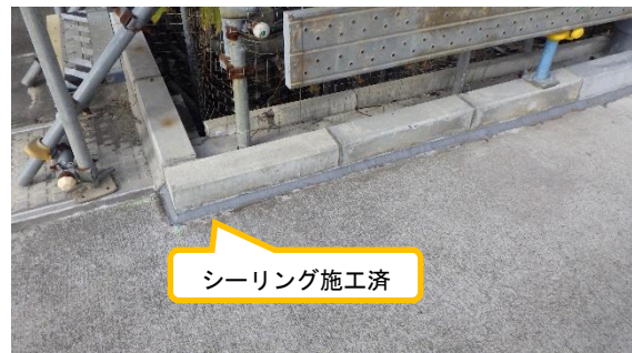
(写真3②) 歩道縁石部分のシーリング工事の状況
