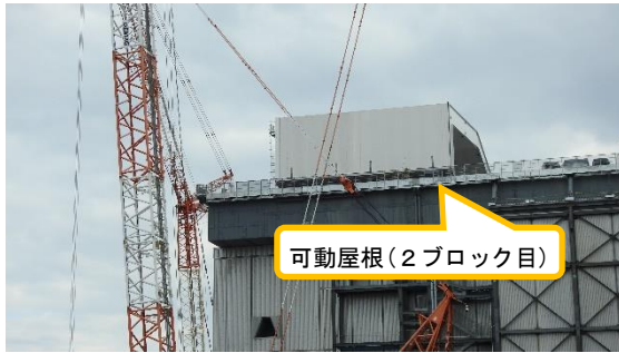
(写真2①) 可動屋根(2ブロック目)の設置状況
