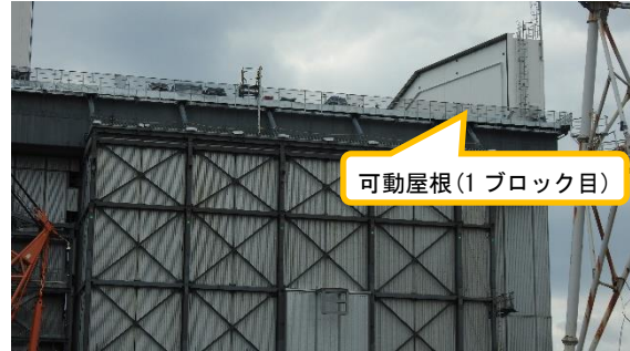
(写真2②) 可動屋根(1ブロック目)の設置状況
