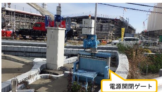
(写真 2) 電動開閉ゲート (C - 1) の状況
