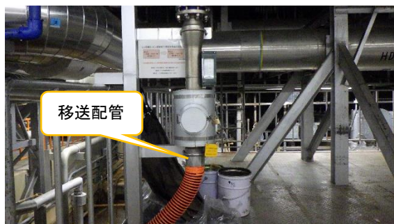
(写真5-1) 5号機タービン建屋地下階における滞留水移送配管の状況
