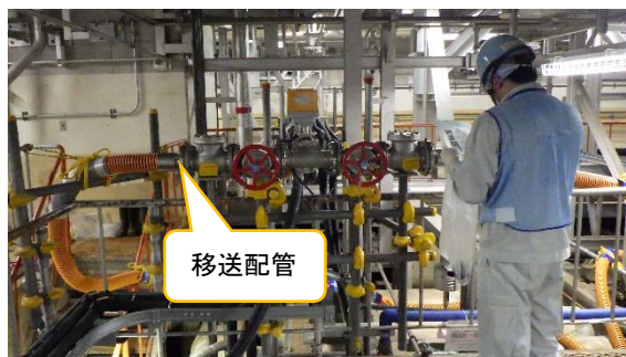
(写真5-2) 6号機タービン建屋地下階における滞留水移送配管の状況
