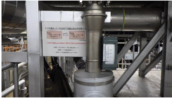
(写真4) 5号機タービン建屋滞留水移送ポンプ吐出流量計
