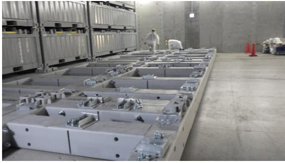
(写真 2-2) ベースフレームの設置状況
