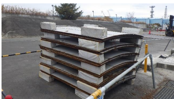
(写真 1 ③) 溶接タンクの解体片
