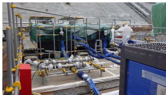
(写真 3－2) 中継タンク建屋での各ピットへろ過水を通水する準備作業の状況②
