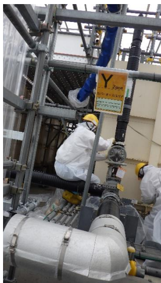
(写真 3－1) 中継タンク建屋内での各ピットへろ過水を通水する準備作業の状況①
