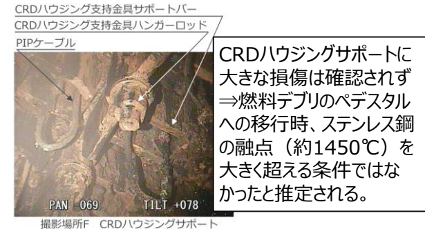
CRDハウジングサポートの外観 [3] （調査時期：2018年1月）
