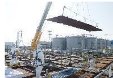
写真1(手順2).ノッチタンク蓋の開放 (参考:ノッチタンク蓋開閉時の写真)
