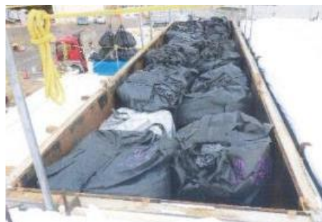
写真2(手順3).ノッチタンクから取り出し (参考:土のう袋のノッチタンク保管時の写真)
