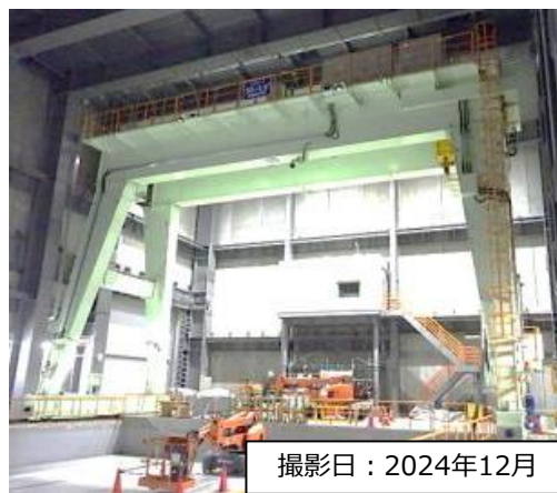
クレーン設置状況
