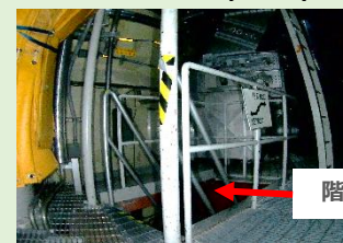
③ 地下階段(南)
