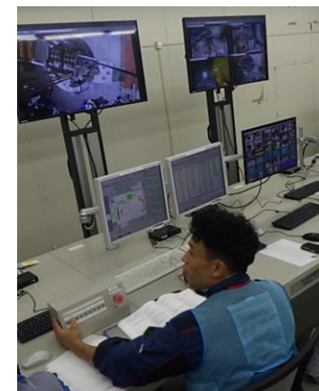
現地動作試験時の燃料取扱設備操作状況
