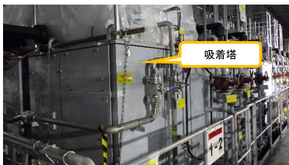
(写真 2 - 1) 吸着塔エリアの状況
