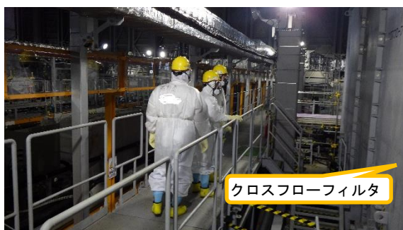
(写真 2 - 2) 前処理装置エリアにおける県職員による設備確認状況
