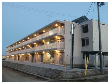
建物全景（北側）
