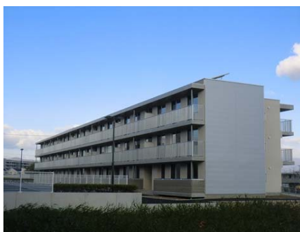
建物全景（南側）
