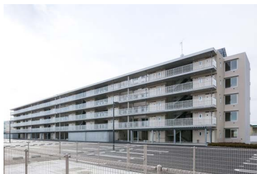
建物全景（北側）
