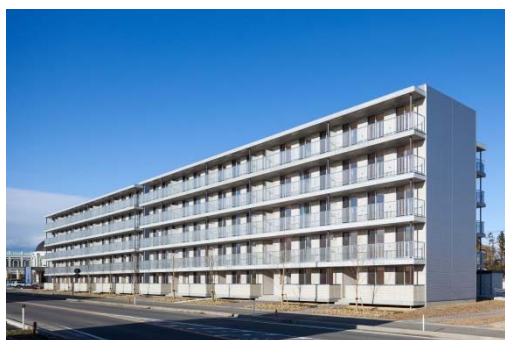
建物全景（南側）
