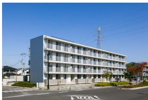
建物全景（南側）
