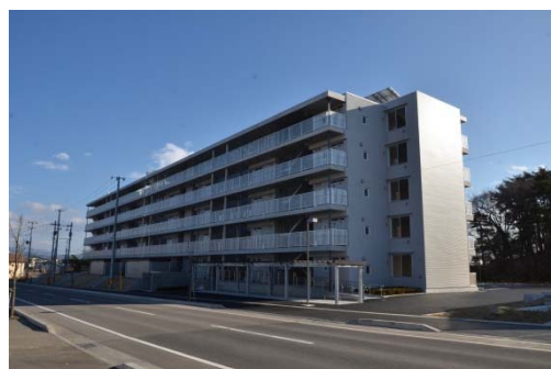
建物全景（北側）
