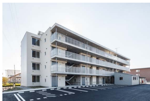
建物全景（北側）
