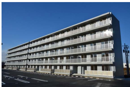
建物全景（南側）
