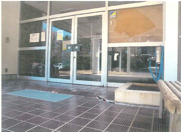
1 管理道路、本館周辺敷地修繕
