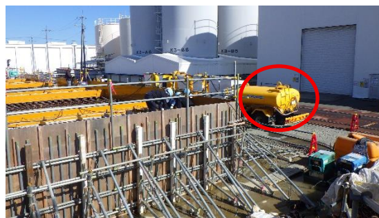
(写真3) 専用車でのコンクリート注入
