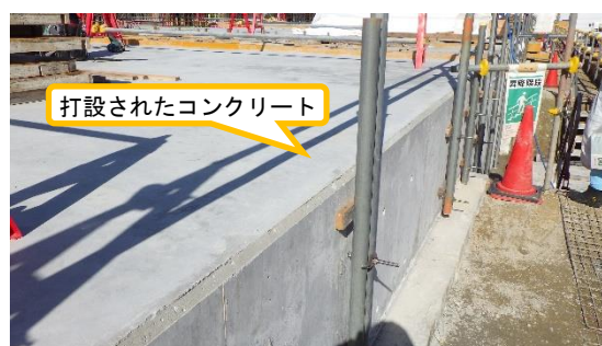
(写真1-4)コンクリート立ち上がり部分
