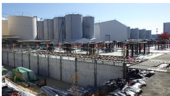
(写真1-3)コンクリート打設の状況①北側
