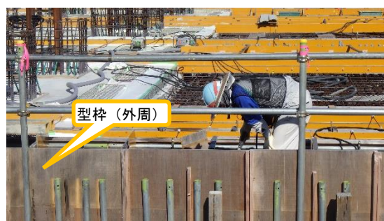
(写真1-2)コンクリート打設の状況②
