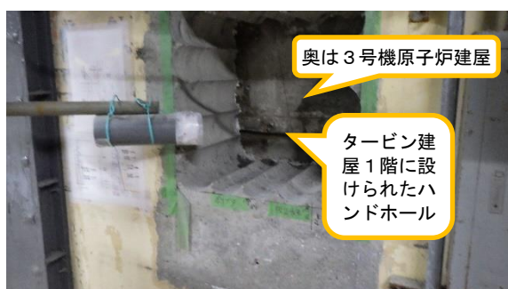
（写真1－1） 施工箇所周辺の状況
