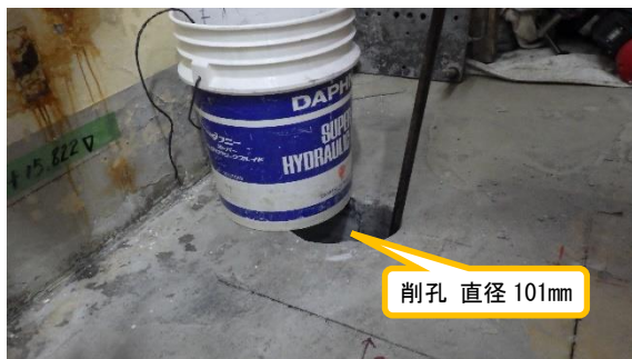
(写真 1－3) タービン建屋 2 階に施工された削孔の状況
