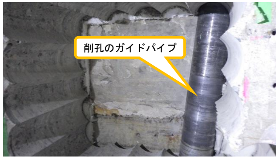
(写真 1－2) ハンドホール内を貫通する削孔のガイドパイプの状況
