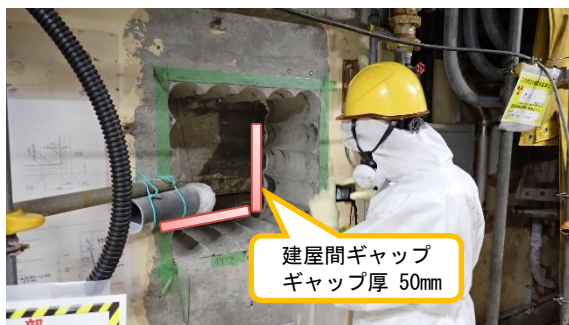
(写真 2－2) ハンドホール内部の状況 (奥の斜線部分 (50mm) が、3 号機原子炉建屋との間隙部)
