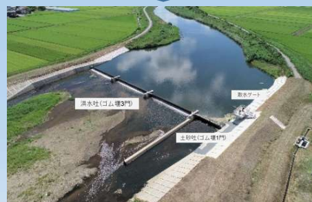
整備後 （可動堰）
