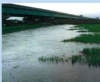
周辺農地の越水被害
