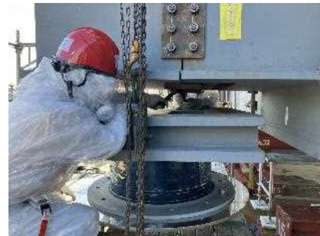
＜弾性支承ボルト締め状況＞
