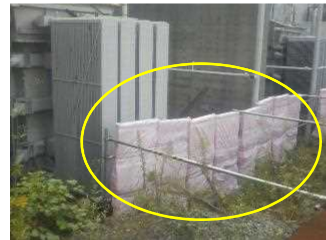
＜法面への衝立遮蔽設置状況＞
