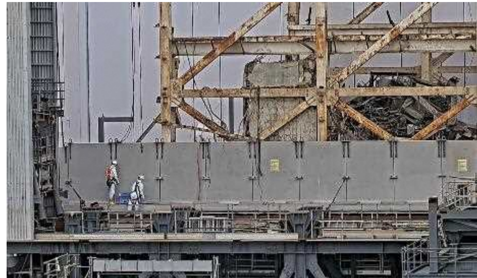
＜下部架構上L型PC設置状況＞
