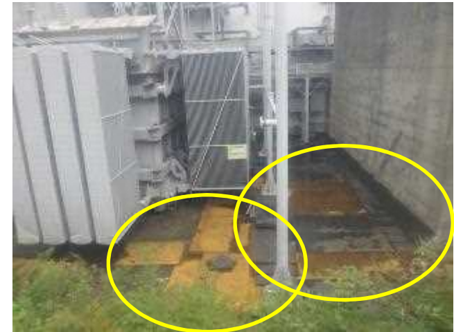
＜床面への鉄板設置状況＞
