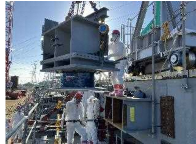
＜弾性支承吊下ろし・取付状況＞
