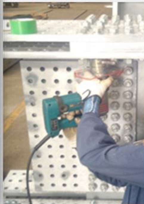
【写真4】上向きでの 締付作業状況
