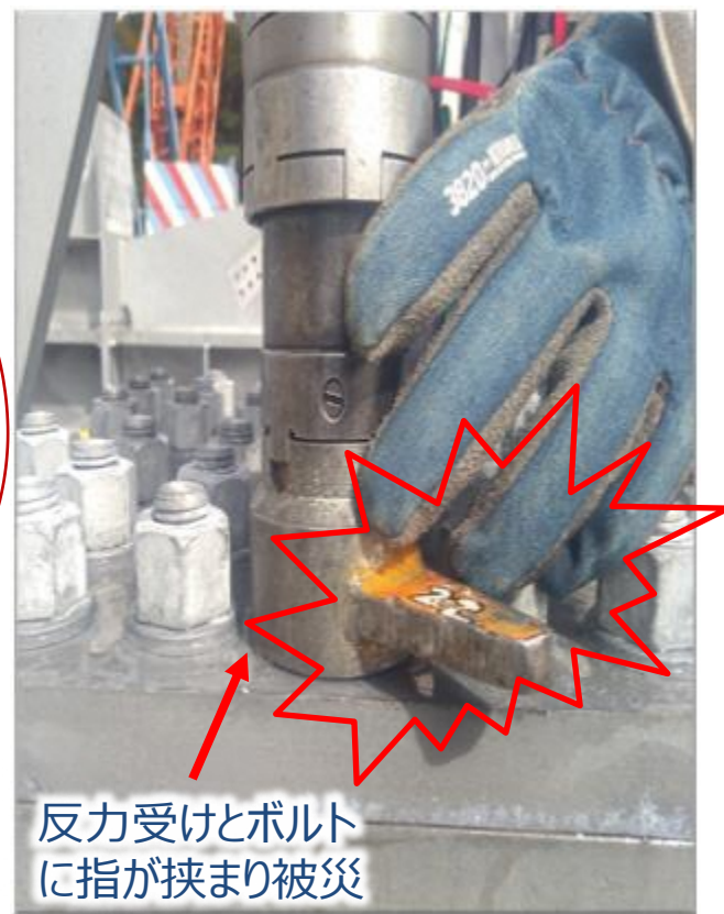
【写真2】災害発生詳細
