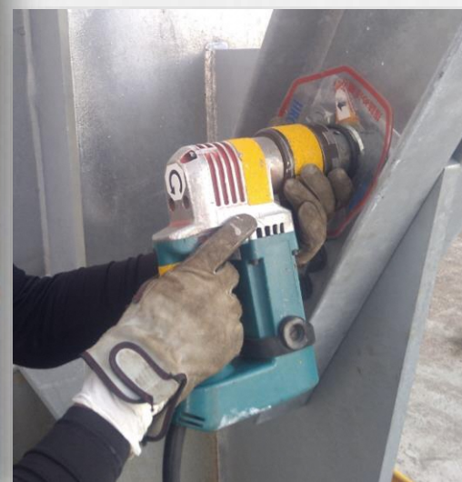
【写真5】横向き + 狭隘部 での締付作業状況
