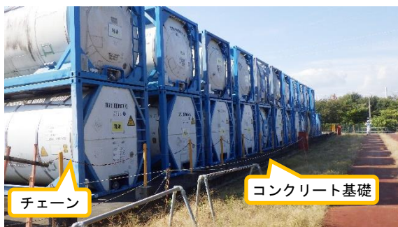
(写真 3－1) No.2 危険物屋外貯蔵所の状況 (北東側から撮影)
