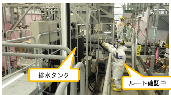
(写真 1－2) 排水タンク周辺の状況
