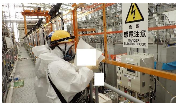
(写真 1－3) ルート確認の状況
