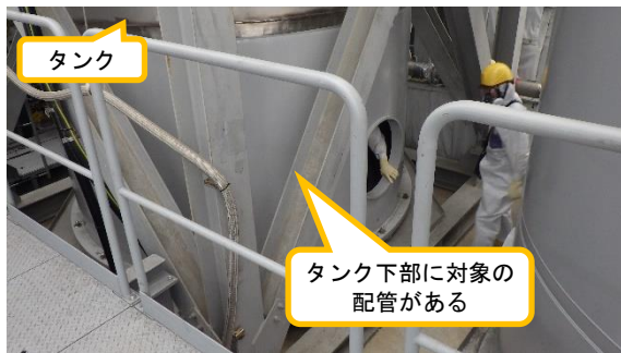
(写真 2－2) 配管フラッシングの状況② ※配管閉塞箇所を確認している様子
