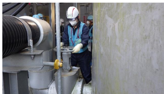
(写真1②) 連結弁の全開作業
