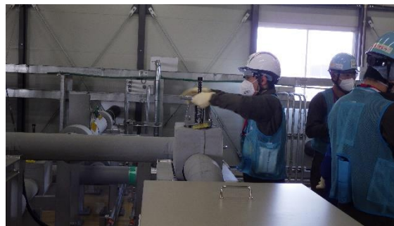
(写真1④) 多核種移送設備建屋での弁操作
