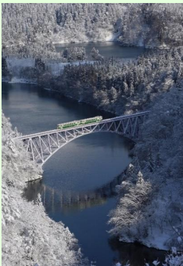
第1只見川橋梁
