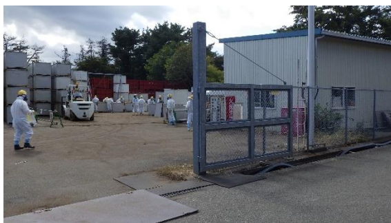
(写真５－３) 一時保管エリアb西側の状況 (作業エリアとして利用)
