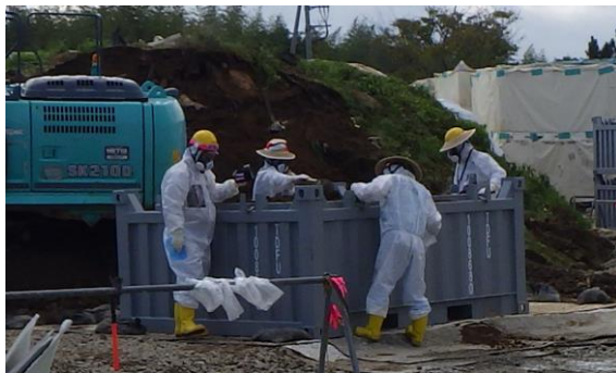
(写真 4－2) 汚染土壌詰め替え作業の状況② (詰め替えた汚染土壌を均一にならしている様子)
