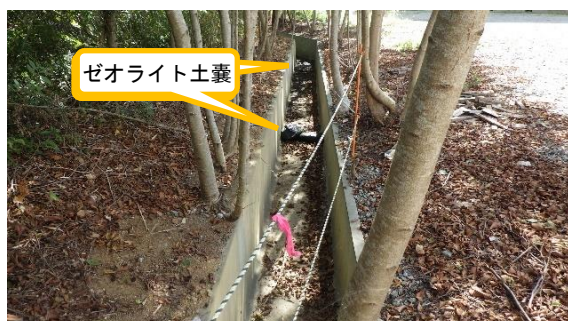
(写真 2 - 1) 排水路の状況 (一時保管エリア P 1 北側)
