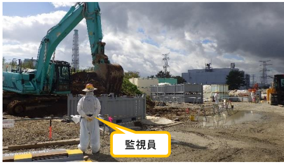
(写真 4－1) 汚染土壌詰め替え作業の状況①
