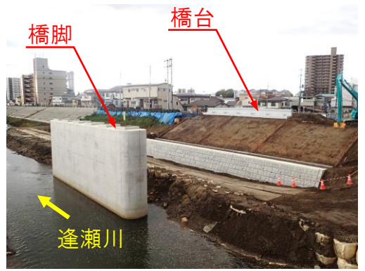
完成した橋脚と若葉町側の工事状況 (R7.10.28撮影)
