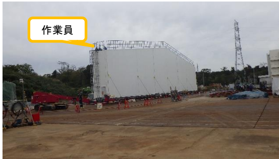
(写真7) 高所作業の状況
