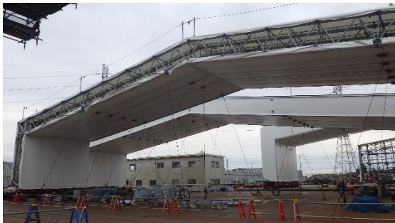
(写真5) 可動屋根の仮置き状況
