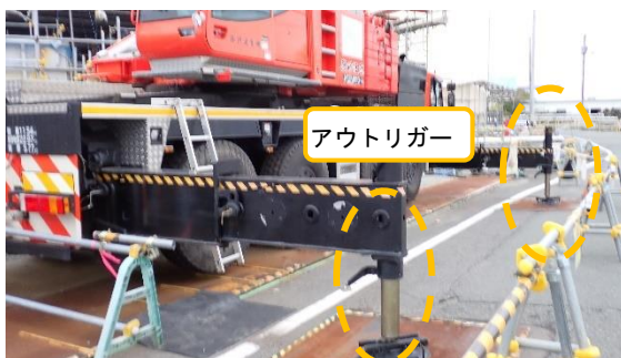
(写真 3) クレーンの設置状況
