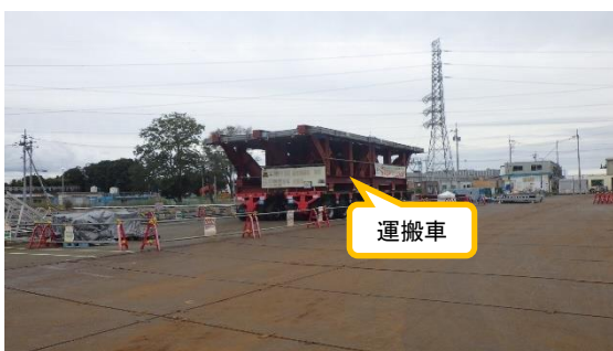
(写真6-2) 運搬車の仮置き状況 ※可動屋根を運搬する際は、運搬車 の上に運搬架台を設置し、その上に 可動屋根を載せる。
