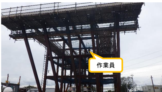
(写真6-1) 運搬架台の組立作業の状況
