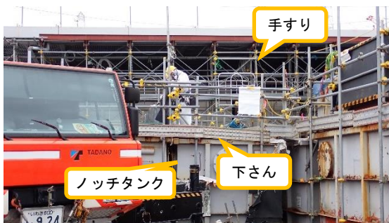
(写真 2) ノッチタンク上部での作業状況
