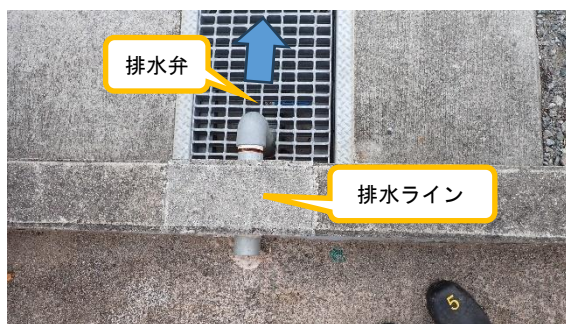
(写真 1－1) 排水ラインの状況 (No. 1 A)
