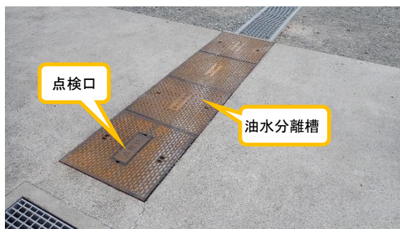
(写真 2) 油水分離槽及び点検口の設置状況 (No. 1 A 及び B)
