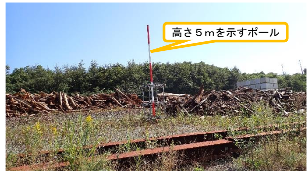
(写真6) 西エリアにおける高さ確認用ポールの 設置状況
