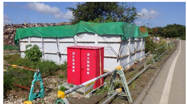
(写真 2) 消火用タンク及び消火器の設置状況
