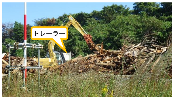
(写真7) 西エリアにおける伐採木の積み込み 状況 ※重機の奥にトレーラーがある。
