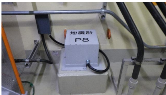
(写真 1 - 3) 地震計の設置状況③ ※ 2 階
