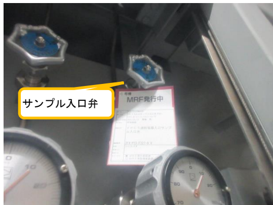
(写真 1) ろ過水脱塩器入口サンプル入口弁
