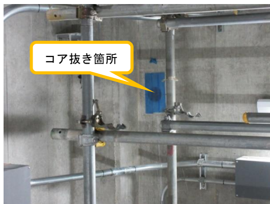
(写真 3) コア抜きの現場状況 ※床面から2.5m程の高さ。
