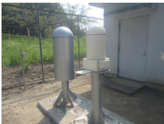
(写真 5 ①) 空間線量測定機器の設置状況
