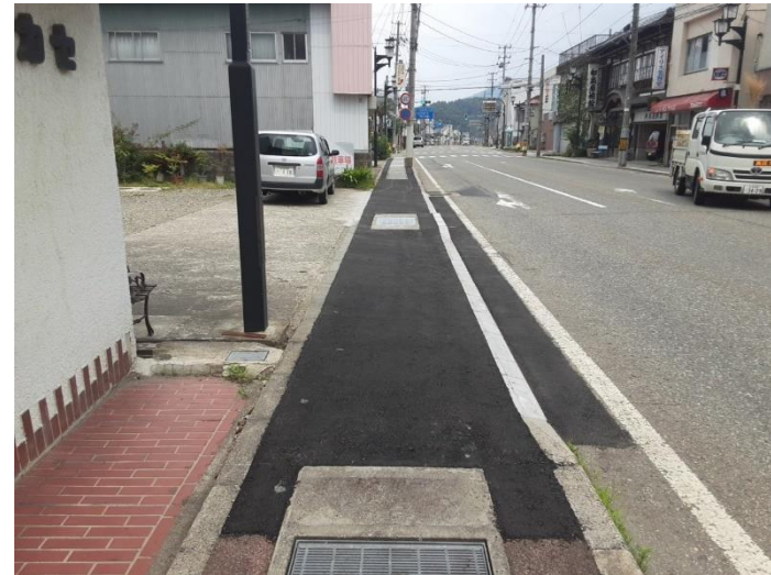
R7工事完了後
