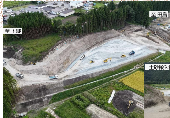
南会津町榑ヶ島地区(道路改良(盛土)工施工状況)
