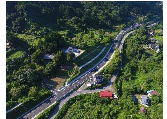
國道349号 (川俣町大綱木工區) 2023年3月21日 完成
