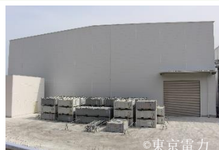
固體廢棄物儲藏庫 第10-C棟的外觀
