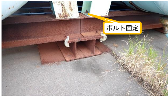
(写真 4 ①) 鉄骨への固定状況
