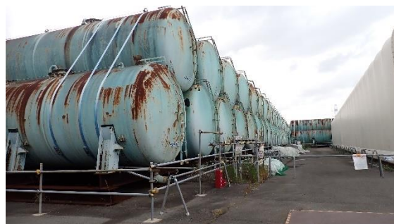
(写真3②) タンクエリアCの状況② ※南東側から撮影
