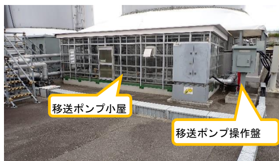
(写真2②) 移送ポンプ小屋の設置状況
