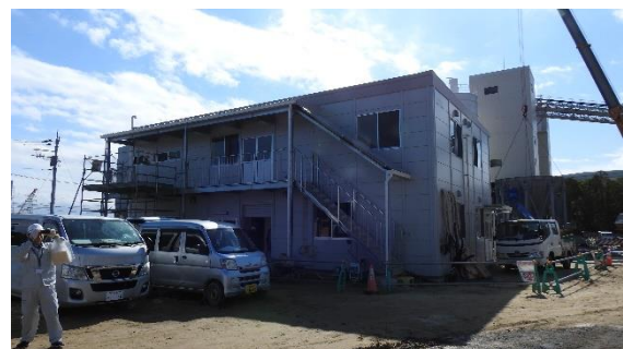
(写真 6) 管理棟の設置状況
