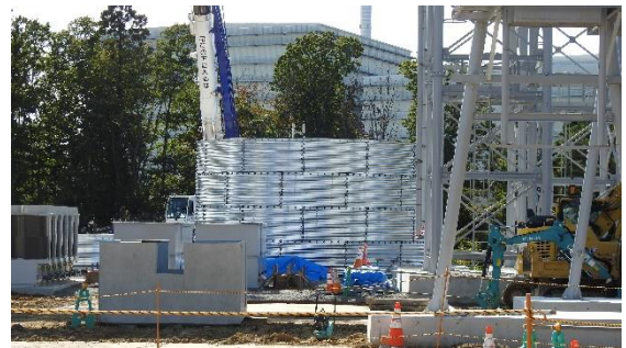
(写真 4 ②) 貯水タンクの設置状況
