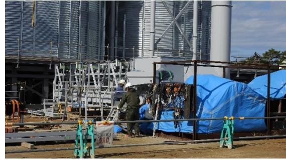
(写真 3 ②) コンベア設備の組立作業
