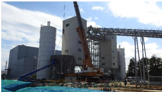
(写真 4 ①) バッチャープラントの設置状況
