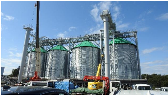
(写真 3 ①) 骨材貯蔵設備の設置状況
