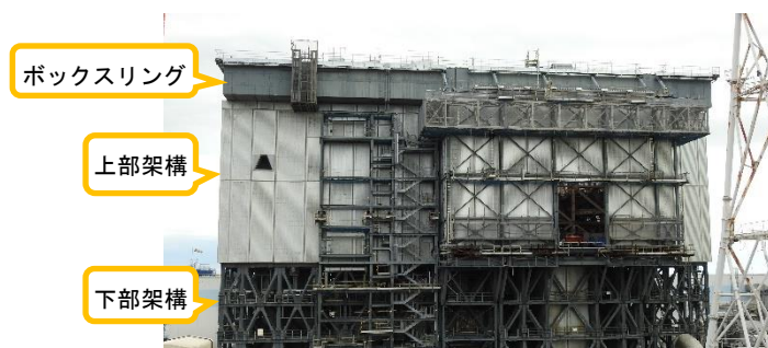
(写真1) 大型カバー全景
