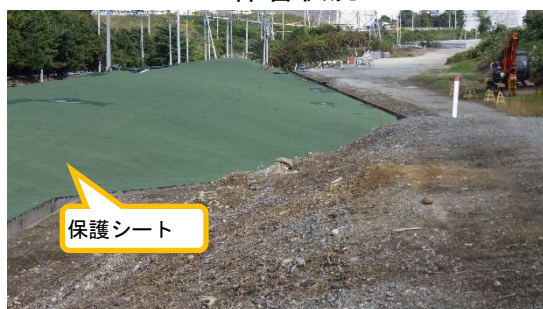
(写真 3－1) 道路側へ火災防止用 保護シート敷設状況
