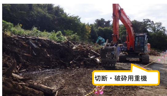
(写真 1－3) 重機による木材の 切断・破砕状況①
