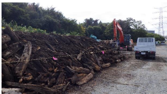
（写真 1－1）エリアMの状況①
