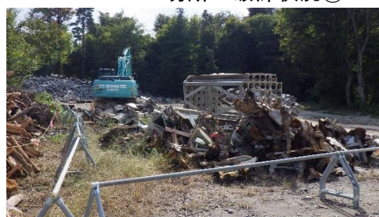
(写真 2－2) エリアM内の瓦礫類 減容処理用区画
