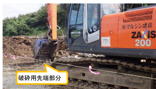
(写真 1－4) 重機による木材の 切断・破砕状況②
